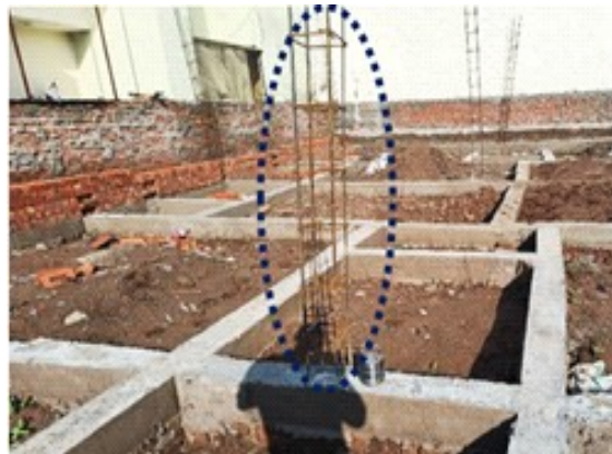
चित्र 19 : मोहाली में निर्माणाधीन इमारत में कॉलम की उपयुक्त नींव नहीं है और इसमें पर्याप्त स्टील रिइन्फोर्समेंट की कमी है।
