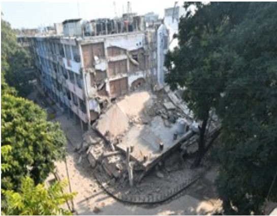
चित्र 20 : सेक्टर 17, चंडीगढ़ का भवन मजबूत बीम (स्लैब) और कमजोर कॉलम के कारण ढह गया।
