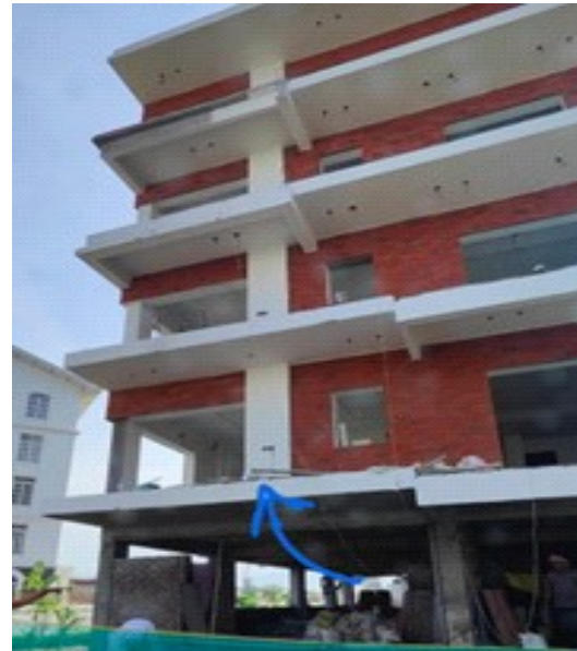
चित्र 23 : पंचकुला में एक आरसीसी बहुमंजिला इमारत में फ्लोटिंग कॉलम।
